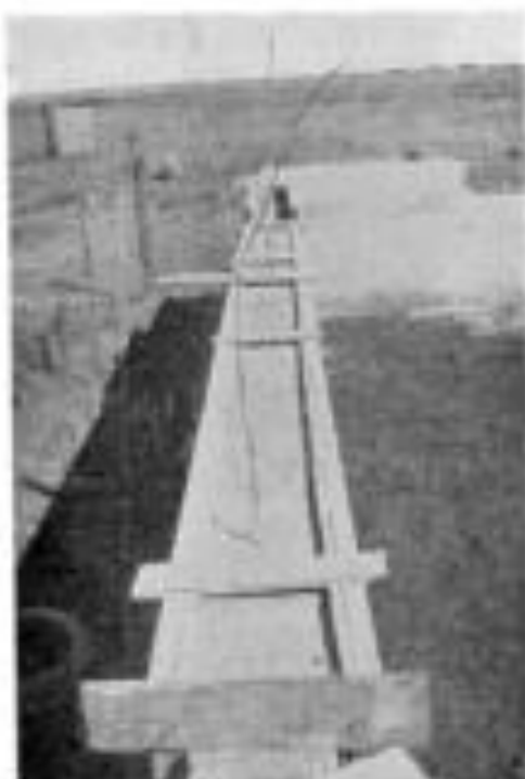
Fig. 1.—Die boere moet hierdie vorm gebruik om die vloer te maak met die mengsel. Let op die deursigtige waaraan die buite vasleë.
